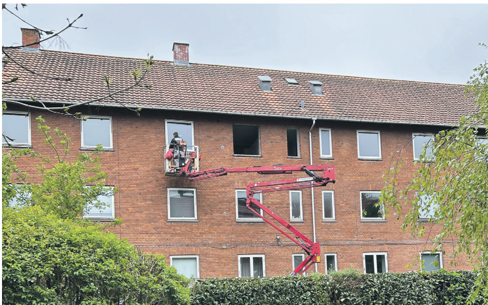
36 lejligheder fik udskiftet vinduer på kun 36 dage. Fotos: Vestegnens Vinduer A/S
